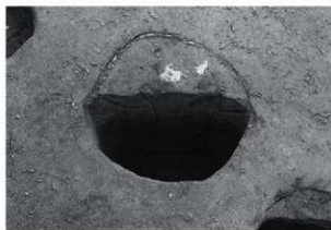
P16土層断面 (西から)
