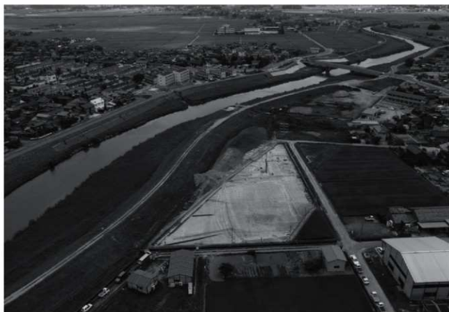
調査地上空から東方を望む（1995年撮影）
