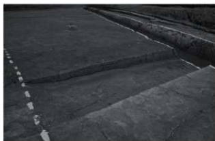
W区旧河道確認状況 東部
