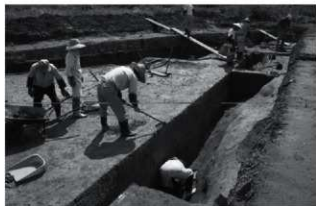
I区作業状況
