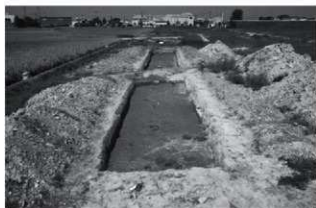
水路E区 (南東から)
