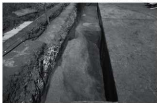
I区河道岸核出状況
