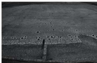
W区中央部 (西から)
