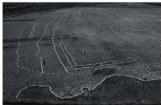
W区北部 (西から)
