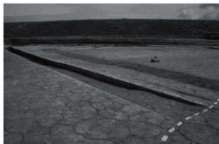
W区旧河道確認状況 西部
