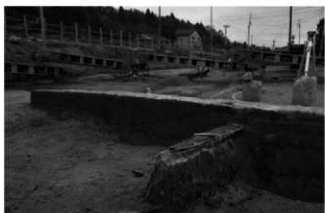
盛土部土層断面 (東側部)
