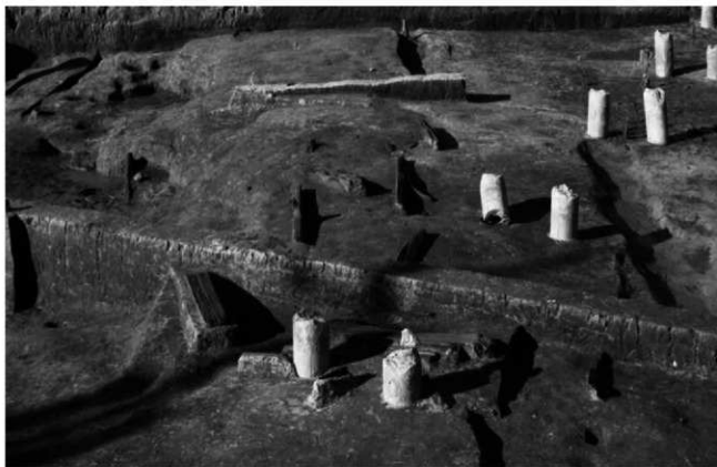
古代道路盛土 材など出土状況
