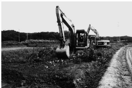
西調査区表土除去作業状況
