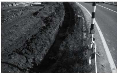
5区全景西より
