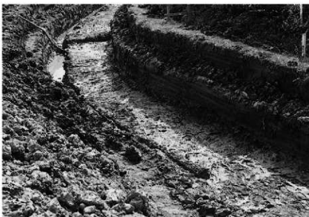
張り出し部先端完露状況
