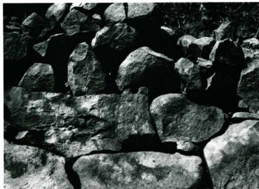
(上) 第38区 土壘状遺構部分写真
