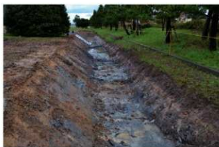
東側調査区表土除去終了 (南西から)
