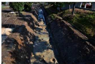
西側調査区完掘状況 (北東から)
