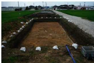
掘削終了ハ区 (南から)
