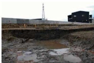
SD201土層断面工 (南から)
