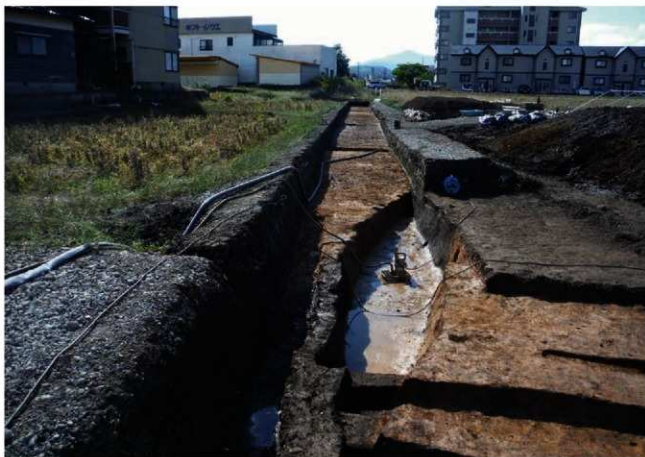
掘削終了タ区 (北から)
