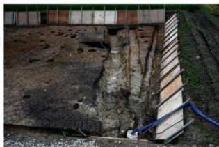
ホ区S0201・202完掘状況 (東から)
