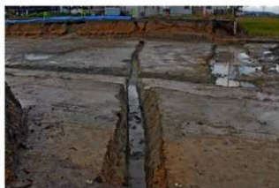
3号溝完掘状況 (北東から)
