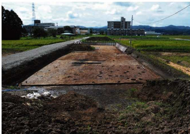
掘削終了リ区 (北から)
