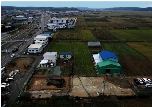
調査地上空から西方を望む
