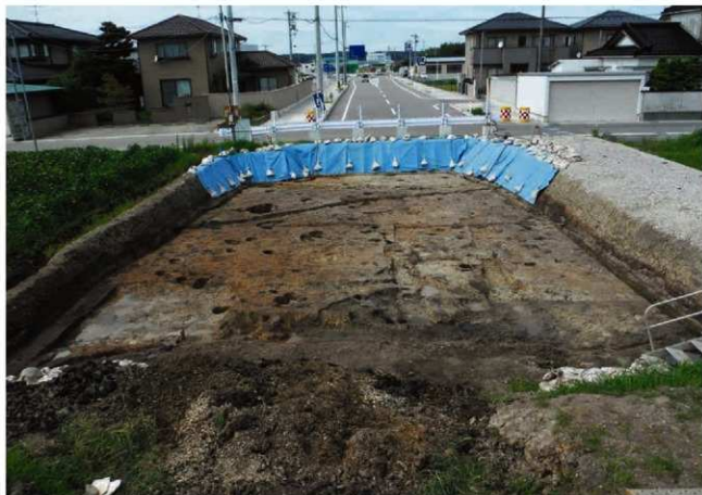
掘削終了ト区（南から）
