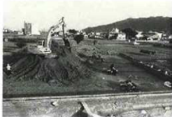
写真11 表土削ぎ取り
