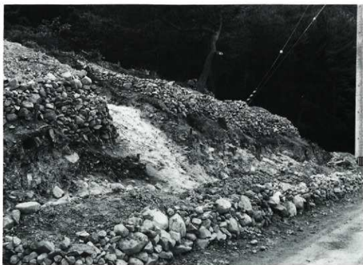
第23区全景 (調査後)
