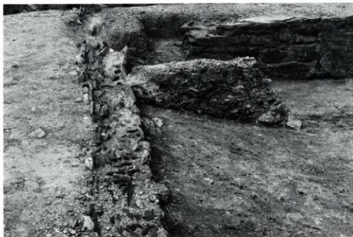
排水遺構（東より）
