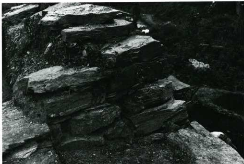
東側外石垣拡張部（南より）
