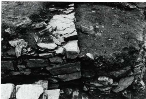
石垣拡張状況（東より）
