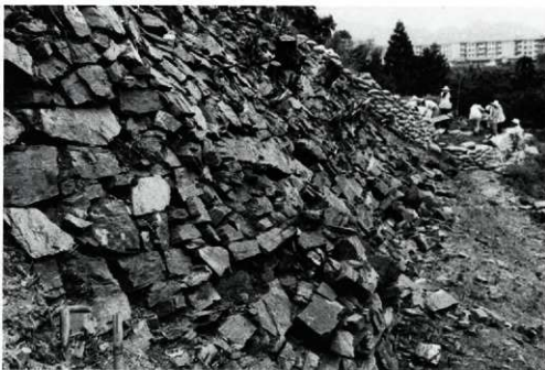
55-8 番地南北石垣 (南より)
