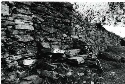
北側外石垣東階段（北より）
