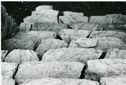
北側外石垣東階段（南より）
