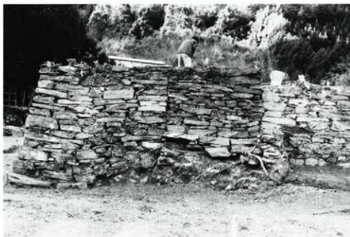
北側外石垣東階段（北より）
