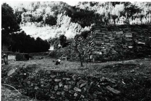
北・東側外石垣（北より）
