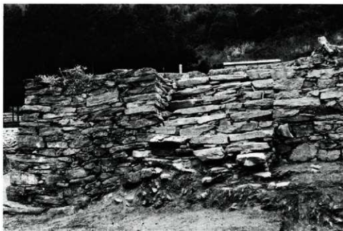
北側外石垣東階段（北より）
