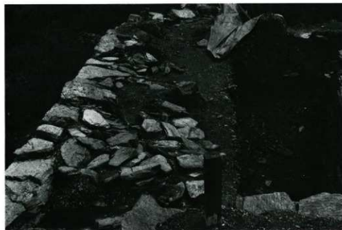
北側外石垣と内石垣（西より）
