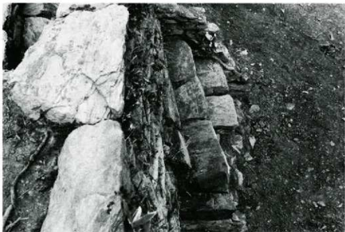
北側外石垣東階段（東より）
