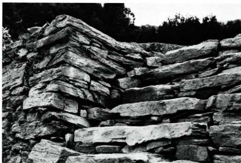
北側外石垣東階段（北より）
