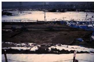
F・G-21・22区遺構検出状況(南東から)
