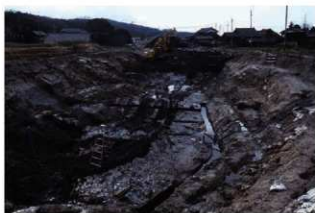
調査区埋め戻し作業風景(北から)
