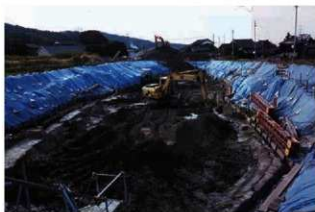
第Ⅵ-1・2面間の間層除去作業風景(北から)
