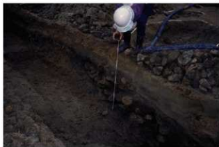
第0-1面ベース土確認調査F-24区トレンチ1土層断面・堤防部分(西から)
