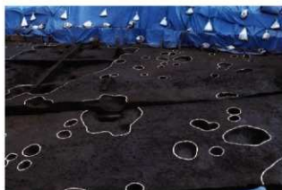
F-21区完掘状況(北西から)
