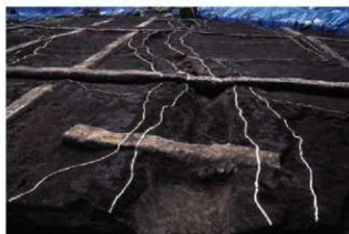
F-26区土層断面(17-17'・2-2'、SD5001、東から)
