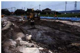
間層(洪水土砂)除去作業風景(北東から)
