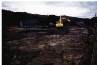
間層除去作業風景(北から)
