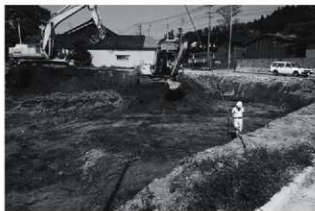
第Ⅱ面表土除去作業風景(南西から)
