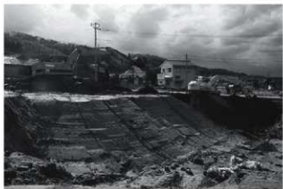
調査区埋め戻し作業風景(北西から)
