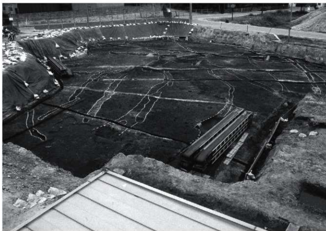
第Ⅱ面完掘状況(北西から)
