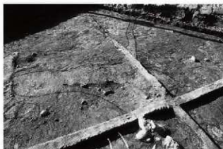
A地区整地土掘り下げ状況（東から）
