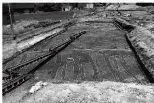
A地区遺構検出状況 (南から)
