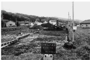
A・B地区表土除去作業 (北から)
