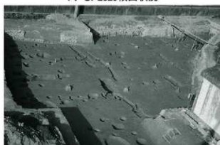
3. 第1調査区完掘状況
