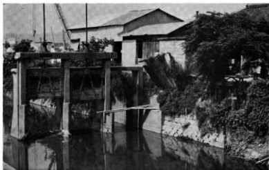
恩智川戸堰（宇河32の西）
