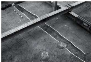
図4.3 DC1完掘状況。東西方向にのびる北西より撮影。
