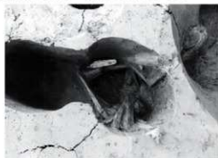
図 4.19 EP21 で検出された木片。EP22 の例と同様、柱の沈下を防ぐためのもの。
