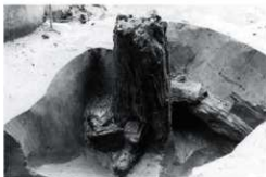
図 4.20 EP13 で検出した根組み柱。建物の沈下を防ぐための工夫がみられる。柱は K145。
