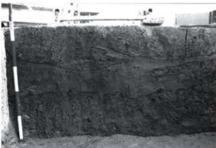
図4.4 EP4埋土断面。漏水を防ぐために埋土の中間付近に粘土が貼られている。
