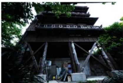
本館の通し柱3本と補強の添え柱、筋違、こげ茶色の柱が通し柱
