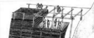
図3 奈前御所ケ谷神籠石土塁築造復元図
