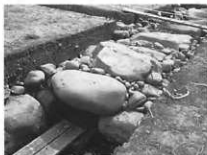
⑨ 第1水門 通水溝
