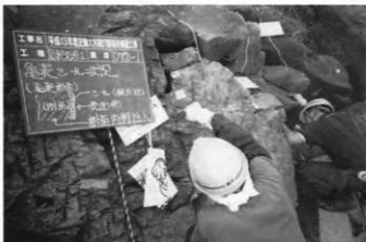
風化防止の最新技術を用いて横穴群の掘られた岩盤を保存する。 史跡 大村横穴群（熊本県人吉市）
