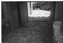
⑤ 西門 内部
