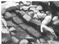
⑩ 第3水門 通水溝
