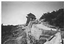
⑦ 城壁の外側に石敷きの通路がある
