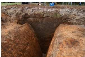
7号溝 Bセクション (北から)
