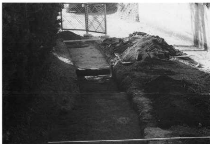
5区 表土除去後 (東より)
