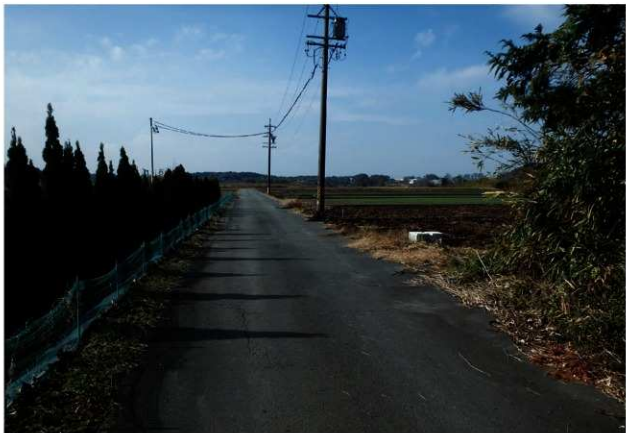
工事施工後の状況（東から）
