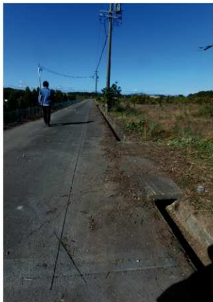
調査前の状況 2（東から）
