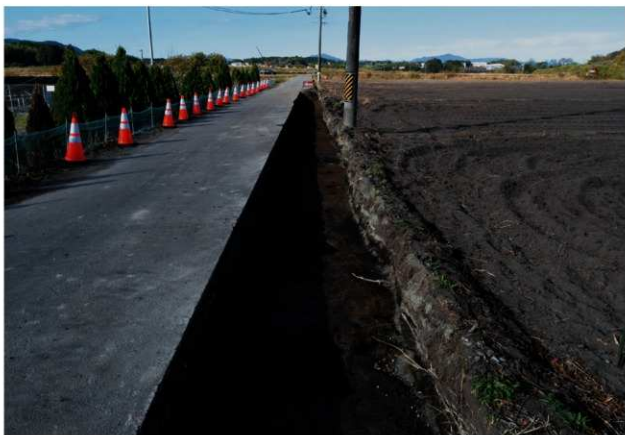
調査区西端の状況（東から）
