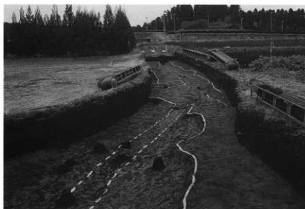
Ⅲ層上面遺構完掘状況 (南より)
