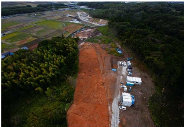
第2次調査区全景（上空東から）
