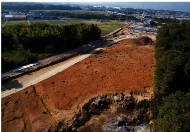
第4次調査区全景（上空東から）
