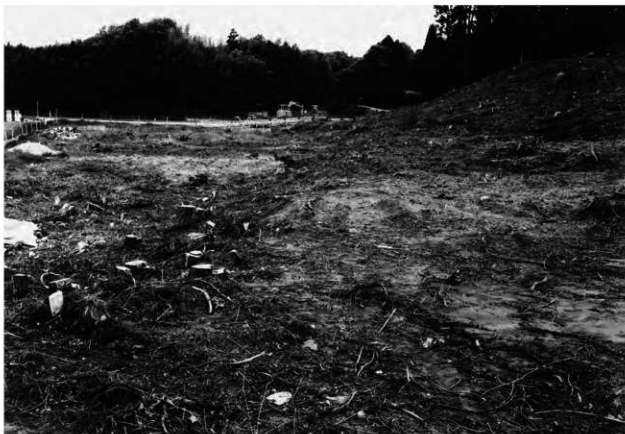
斜面裾部調査前状況（東から）
