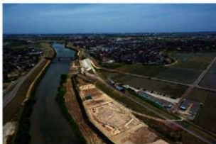
調査地遠景 上流側から一針町方向を望む(南東から)
