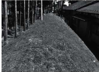
8. 西小屋館跡 北辺土塁（西から）
