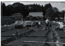
12. SE45 井戸跡 調査風景
