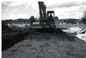
写真10 表土掘削作業（5区）
