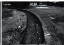
5. SD93 溝跡 完掘状況 (南部・南から)
