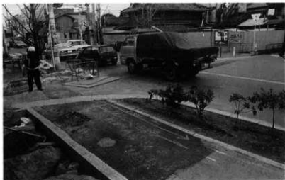
若江遺跡 45-1次A区 調査地近景
