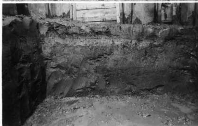
45-1次C区 西壁(下部)
