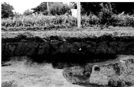
第 136 次調査 SD6050 東壁土層 (西から)
