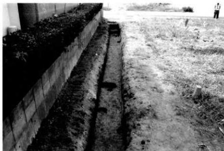
第 162-3 次調査 359-1 路線 調査区西半 (東から)
