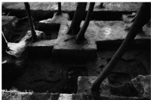
S B11360 西妻柱筋 (北東から)
