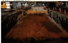
写真35 1 T 調査状況（2）
