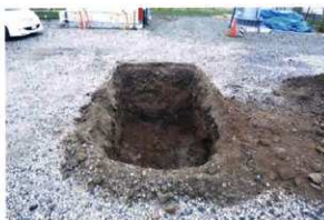
写真 71 1T 調査状況
