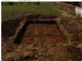
写真 142 1 T 調査状況
