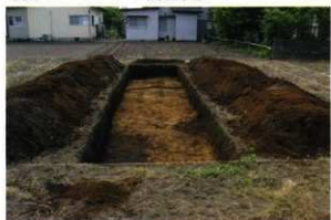
写真 131 2T 調査状況
