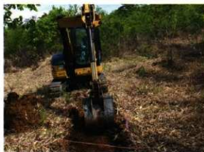
写真 184 表土除去作業
