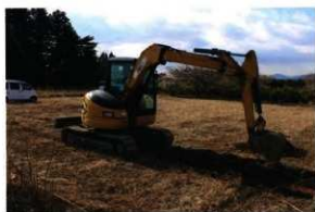
写真 77 重機掘削状況
