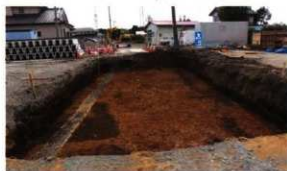
写真34 1 T 調査状況（1）
