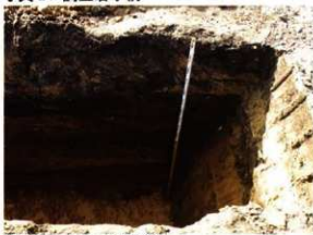
写真25 1T 調査状況
