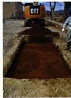
写真2 1T 調査状況
