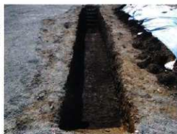
写真55 1T 調査状況
