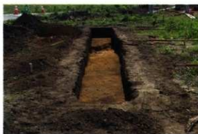
写真 145 1 T 調査状況
