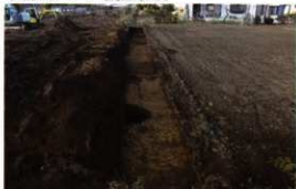
写真20 3 T 調査状況
