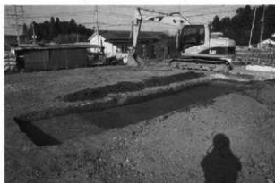
5. 2T調査状況
