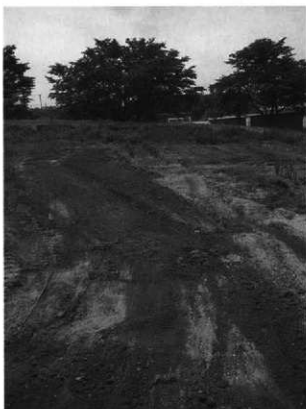
4. 埋め戻し状況
