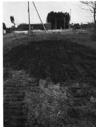
4. 埋め戻し状況
