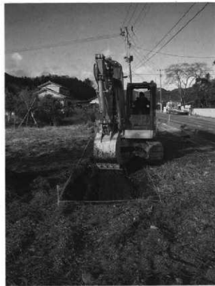
2. 表土掘削状況
