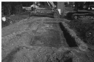
3. 1T調査状況
