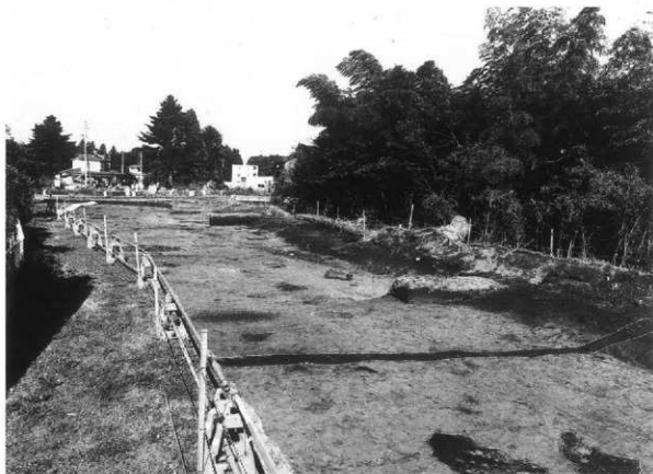
写1 A区②完掘状況
