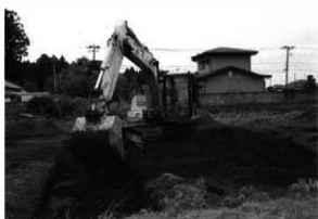
8 埋め戻し作業
