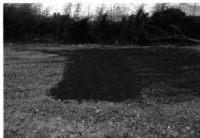
8 2 T埋め戻し状況
