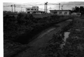
7 5T深掘り状況 (南西から)
