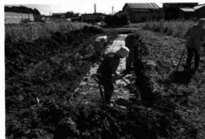
3 2T遺構検出作業
