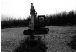
2 表土除去作業
