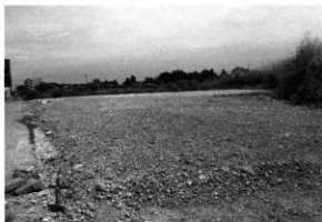
1 調査前の状況
