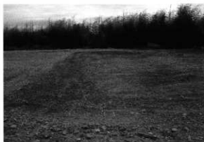
5 1 T埋め戻し状況
