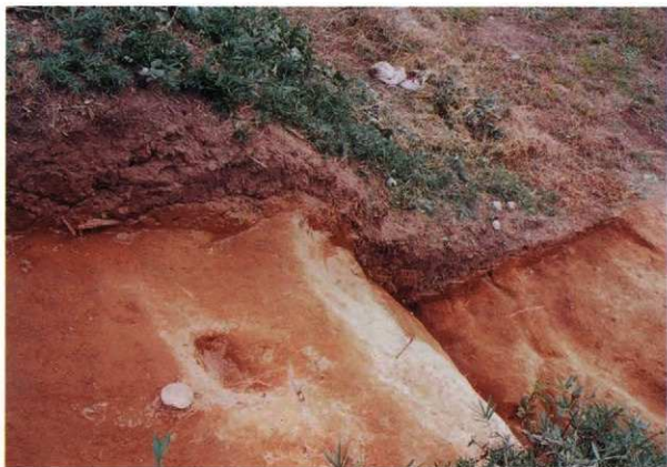
2 21 T 後方部南斜面掘削部
