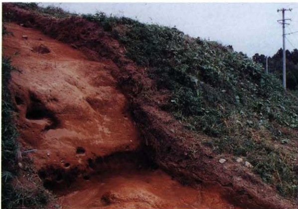
1 21 T 後方部南斜面掘削部
