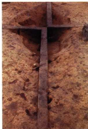
3 1号陥没坑調査状況
