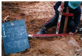
2 盛土造成工 (盛土状況)
