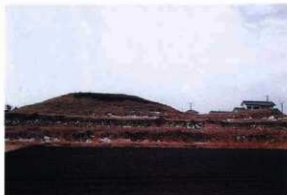
1 盛土造成工 (施工前)
