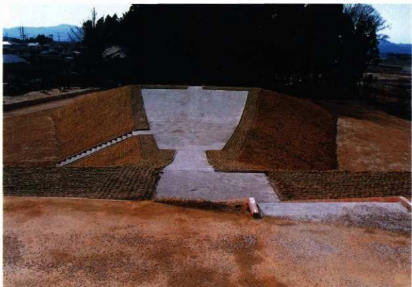
2 填丘施工（後方部→前方部）
