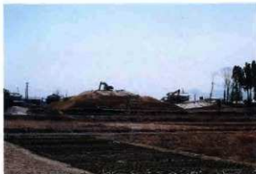
3 造成工事状況
