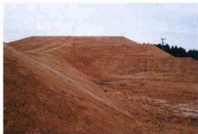
1 盛土造成工（前方部→後方部）
