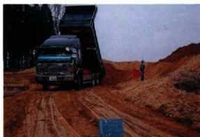
7 盛土造成工 (客土搬入状況)
