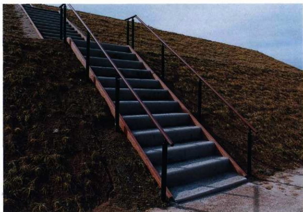
2 階段施工（手摺）
