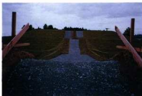
1 路盤工 (前方部→後方部)
