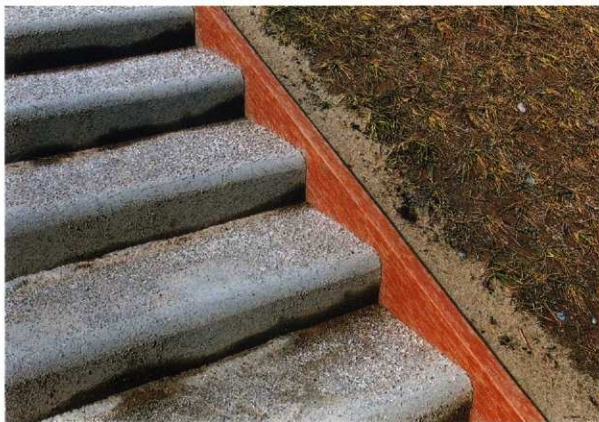
2 階段施工（前方部）
