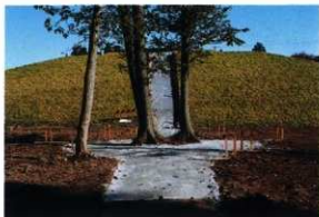
2 路盤工 (前方部西側広場)
