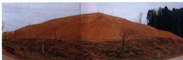
3 盛土造成工（施工後後方部）
