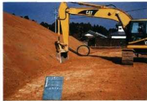
8 盛土造成工 (法面整形)
