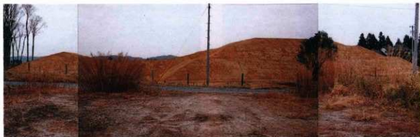
2 盛土造成工（施工後南から）
