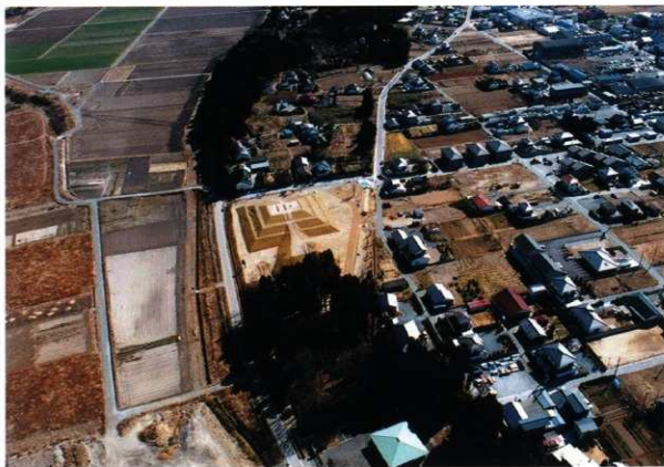
2 施工後空撮2 (西から)
