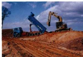
8 盛土造成工 (客土搬入状況)
