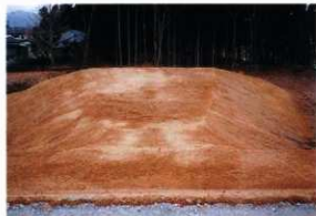
2 盛土造成工（後方部→前方部）
