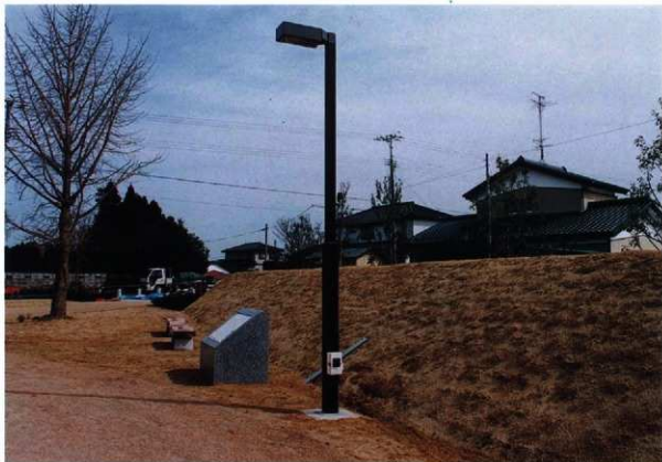
1 照明施設 (防犯灯)
