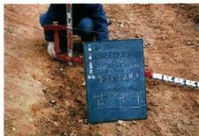
3 盛土造成工 (盛土状況)
