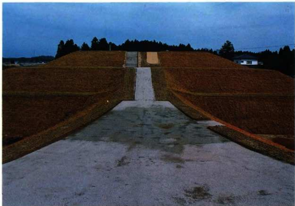
1 填丘施工（前方部→後方部）
