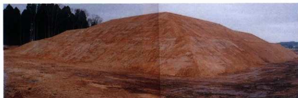
4 盛土造成工（施工後後方部）
