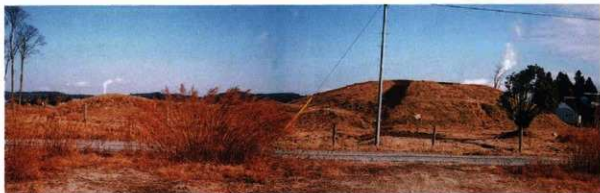
1 盛土造成工（施工前南から）
