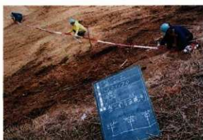
5 盛土造成工 (丁張状況)
