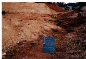
6 盛土造成工 (客土搬入状況)
