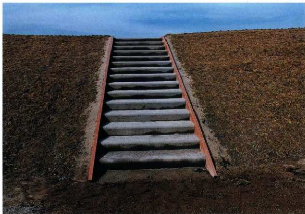
1 階段施工（前方部）
