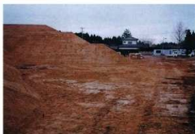
4 盛土造成工（周溝）
