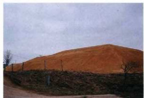
3 盛土造成工（後方部）
