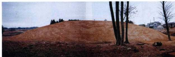
5 盛土造成工（施工後前方部）
