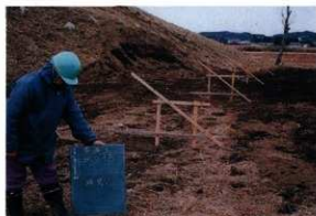
3 盛土造成工 (丁張状況)
