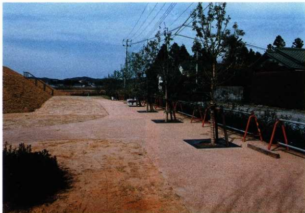
1 舗装 (東側園路)
