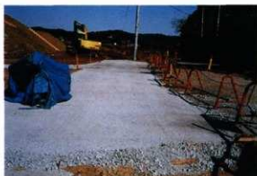
5 路盤工 (東側園路)
