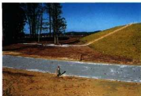
6 路盤工 (南側園路)
