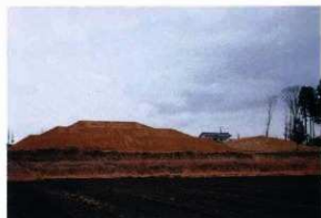
3 盛土造成工（施工後北から）
