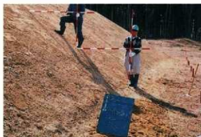
7 盛土造成工（斜面）
