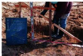
2 盛土造成工 (丁張状況)
