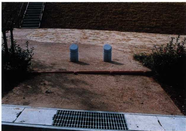
1 車止め（車側出入口）
