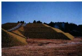
8 路盤工 (後方部・南側主園路)
