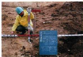
1 盛土造成工 (盛土状況)
