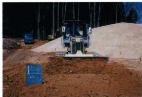
4 盛土造成工 (盛土状況)
