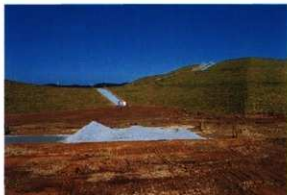
4 路盤工 (南側主園路)
