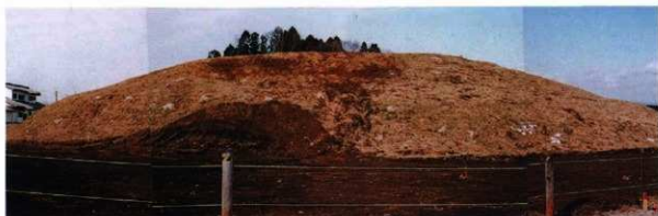
1 盛土造成工（施工前後方部）
