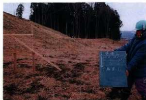
4 盛土造成工 (丁張状況)
