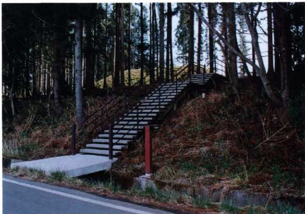
1 7号墳デッキ階段
