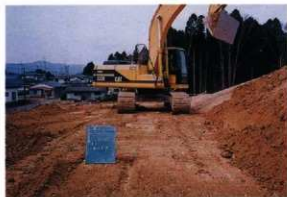
6 盛土造成工 (盛土状況)
