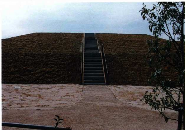
1 階段施工（後方部東側）
