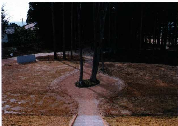
2 舗装 (西側園路)
