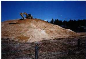
4 造成工事状況
