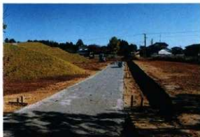
3 路盤工 (南側主園路)
