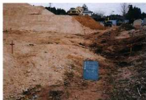
5 盛土造成工 (盛土状況)
