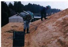
6 盛土造成工（斜面）
