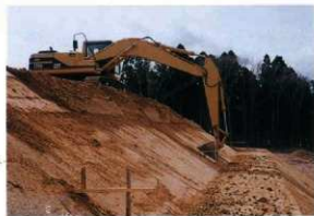
7 盛土造成工 (法面整形)
