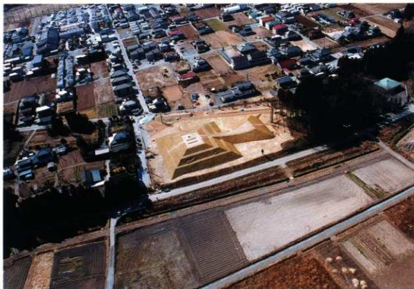
1 施工後空撮1 (北から)
