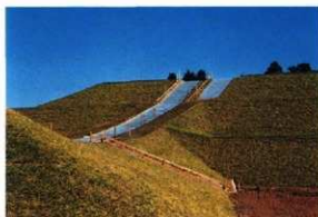
7 路盤工 (後方部西斜面)
