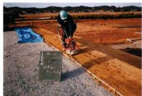
5 盛土造成工（後方部填頂）
