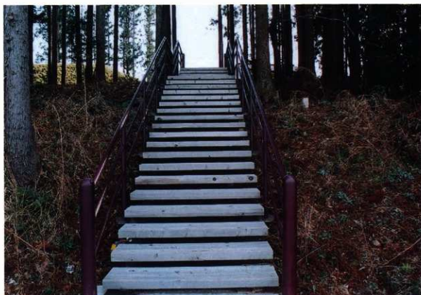
2 7号墳デッキ階段
