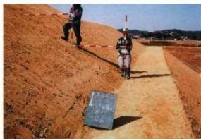
8 盛土造成工（斜面）
