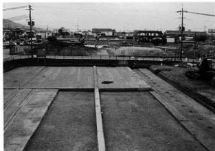
2 A-1区 第2遺構面 全景 (北から)
