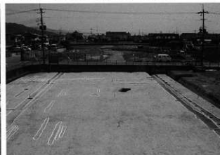
6 A-1区 第1遺構面 全景〔4〕 (北から)
