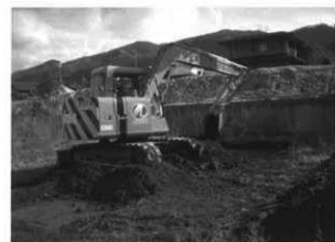
図1.3 調査地西半部での機械掘削の様子。
