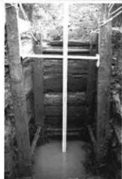
図 2.16 井戸完掘状況 北から
