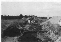
重機による表土剥ぎ
