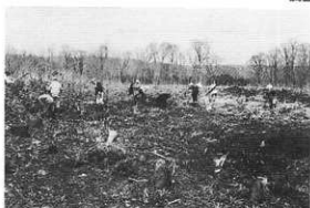
作業風景（雑物撤去）
