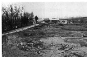
調査前の状況
