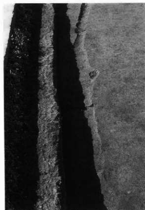
RG163完掘(東から)
