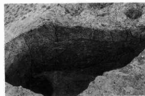
RD251断面(西から)
