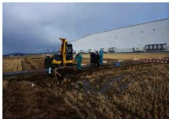
4トレンチ 調査風景 (南東から)
