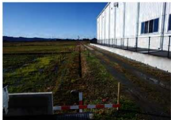
調査地近景 (北東から)
