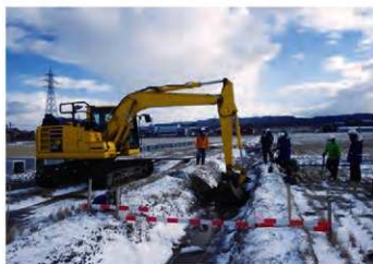
2 トレンチ 調査風景 (西から)
