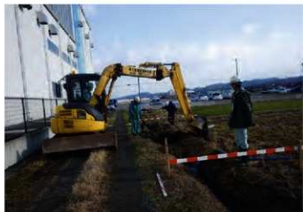
2トレンチ 調査風景 (南西から)
