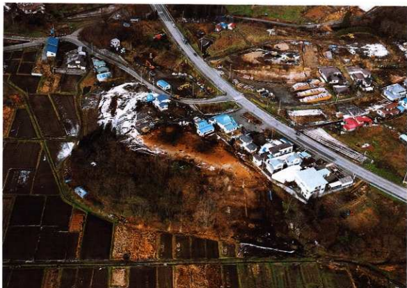
道路近景（市から）
