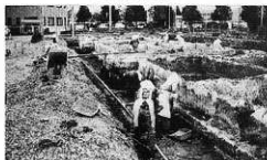
コンクリートの基礎を残しながらの遺構検出作業風景
