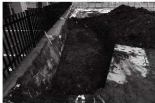
5 トレンチ東掘（東から）
