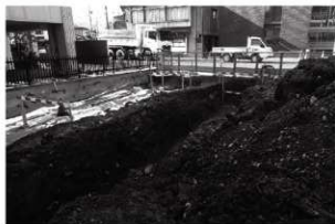
7 工事立会掘削（北東から）
