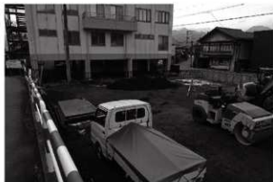
1 調査地近景（北東から）
