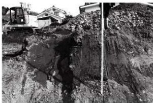
4 地下室掘削近景（西から）
