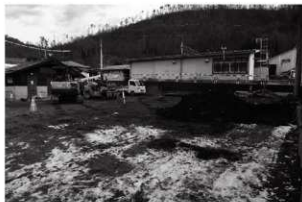
2 調査地近景（南西から）
