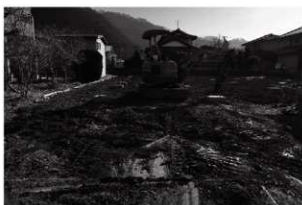
3 調査前 (西から)
