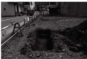
6 Cトレンチ完掘 (西から)
