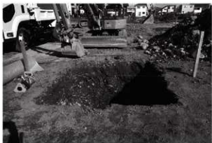
3 浸透樹施工状況（南から）
