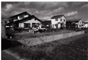
1 施工地近景（南東から）
