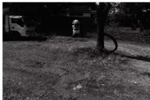
1 ①施工状況（北から）
