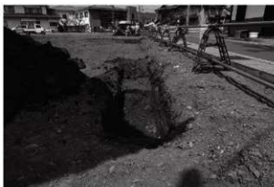
2 Aトレンチ完掘 (東から)
