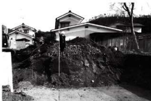
3 地下室掘削遠景（西から）
