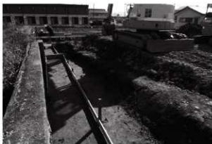
2 北辺擁壁施工状況（西から）
