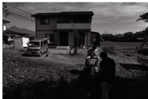
2 ①施工状況（南から）
