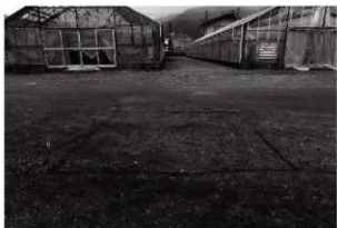
1 調査地近景 (北東から)
