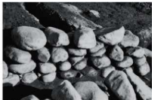
東壁 石積み（西から）
