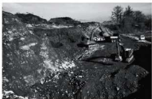
造成による段丘掘削状況（南西から）
