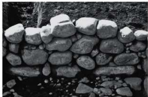
西壁 石積み（東から）
